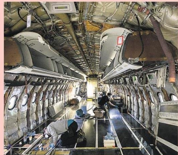
Lennukisalong seestpoolt, kui seinapaneelid ja toolid on välja võetud. Niimoodi pääsetakse ligi lennuki kerele, kus võib tekkida korrosiooni.
